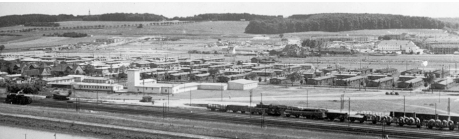
„Stadt des KdF-Wagens“ im Bau
