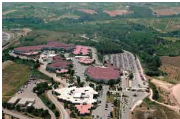
DAS „CENTRO TECNICO“ IN MARTORELL
